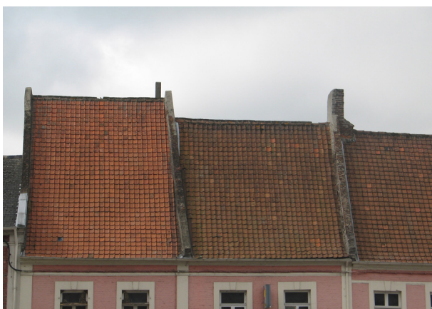
Pignons dépassants, finis au mortier de chaux.
