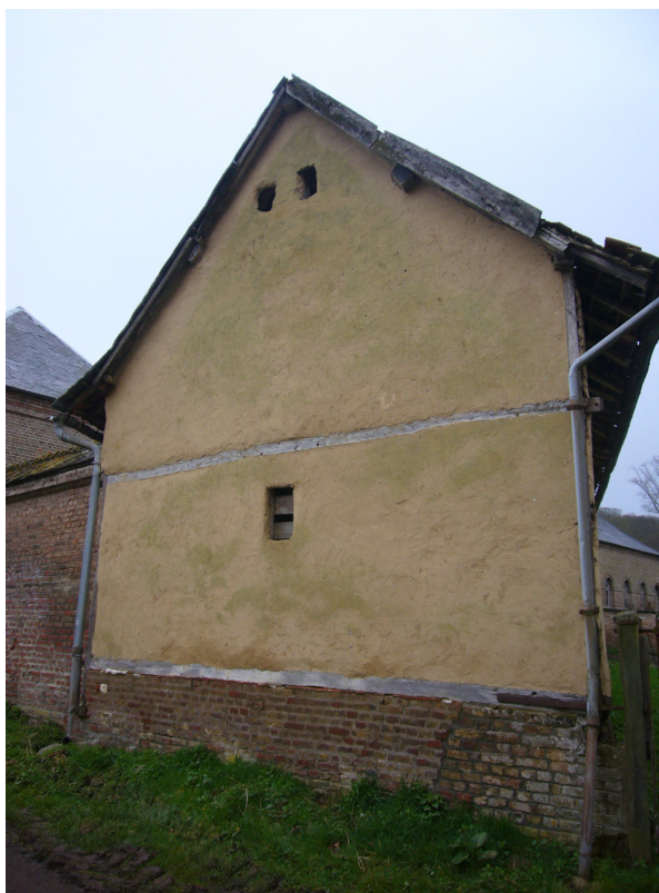
Enduit au torchis, au Hameau de Lannoy, exemplaire par la finition et la teinte.
