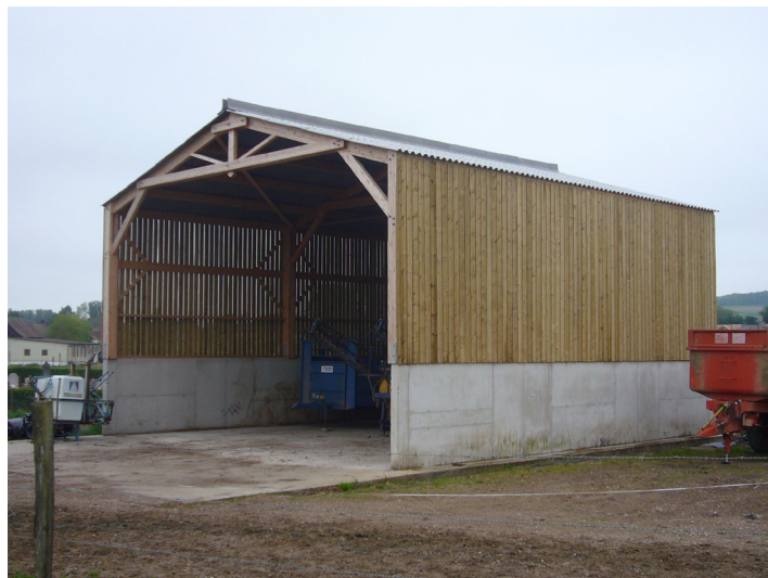
Hangar agricole en bois
