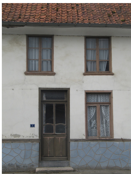
Menuiseries anciennes entretenues
