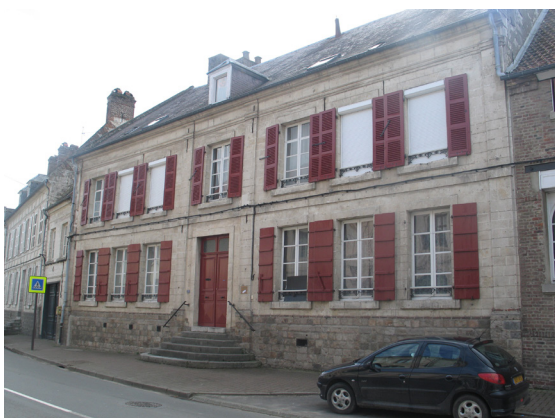
Volets battants à préserver. Volets roulants à déposer.
