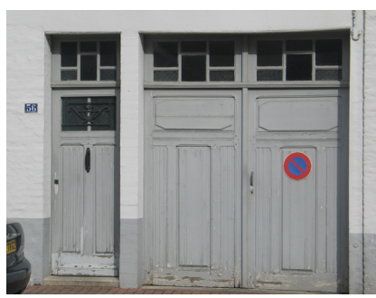
Porte et porte garage en bois peint.
