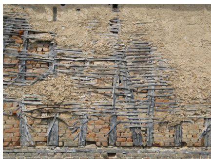
Pan de bois remplis en brique et enduit au torchis.
