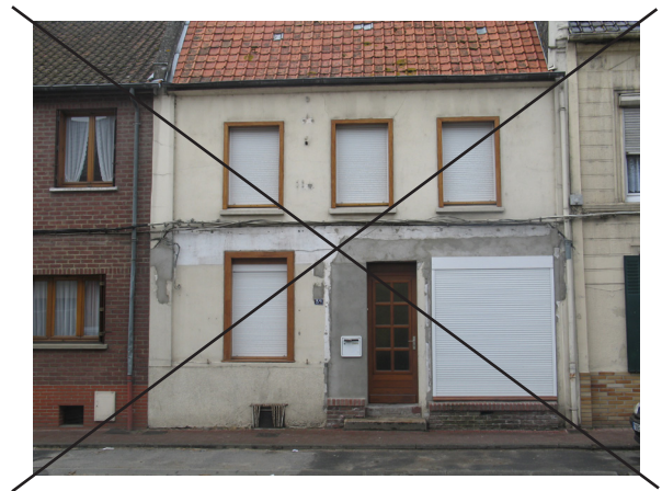
Nouveaux percements, désaxés par rapport aux baies d'origine.
