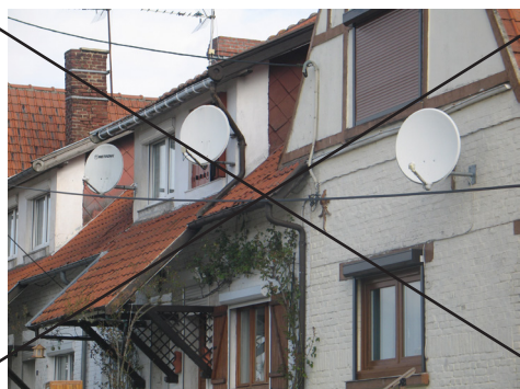
Antennes paraboliques trop présentes en façade.
