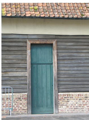
Pan de bois revêtu de bardage bois, belle restauration faite fin XX e siècle, porte et chambranle conservés soubassement brique rejointoyé.
