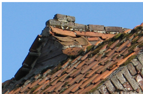
Faîtage en briques posées à plat.
